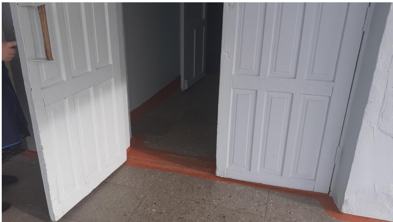
Фото . Дверь (входная).
