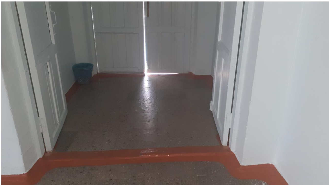
Фото . Дверь (входная). Тамбур
