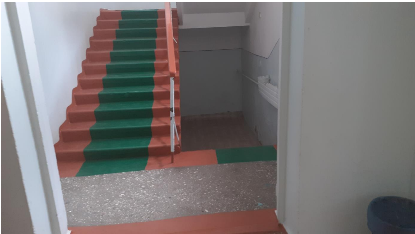
Фото 15. Лестница (внутри здания)
