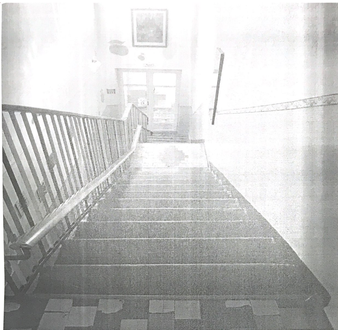
Фото 14. Лестница (внутри здания)
